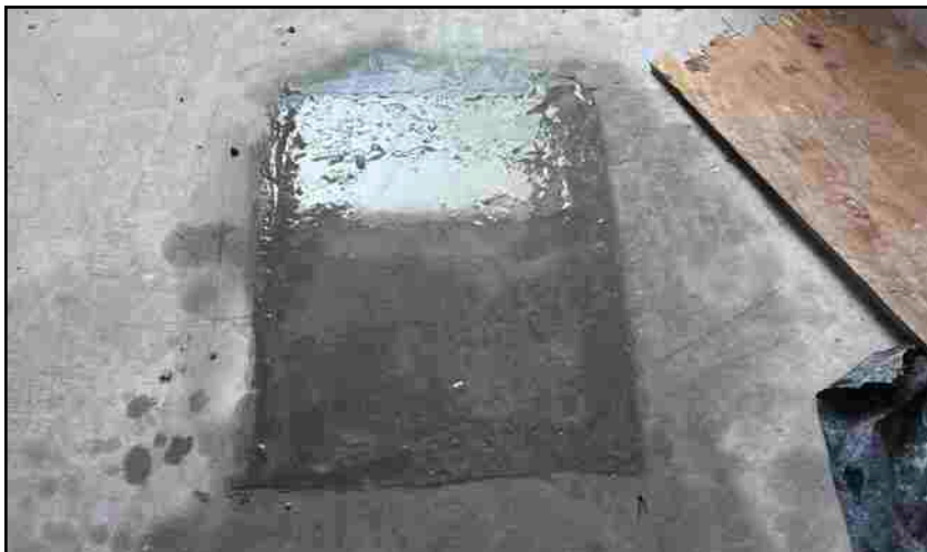
Concrete pour storage room, bldg 29
