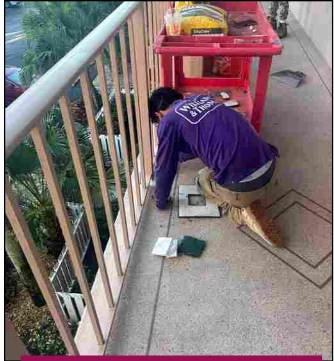
Prepping post pockets for concrete pour
